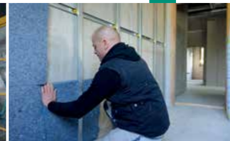
Pose d'isolant, en panneau ou en rouleau, sur les murs, cloisons, toitures, plafonds...
